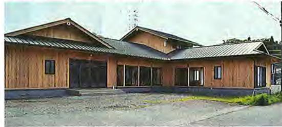
繊維方向に直交するように重ねて接着した大型の木質パネル。断熱や耐震性を確保できるとして注目を集めている。同施設では国産の杉の間伐材を厚さ6センチほど重ねたパネルを製作。さらに社寺仏閣などで使われた日本の伝統的な落とし込み構法で建設した。
